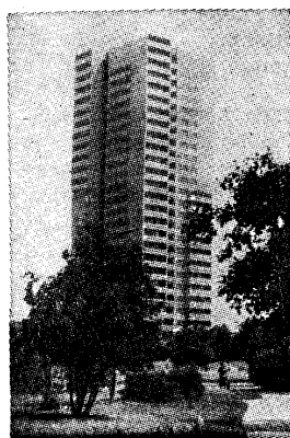
Рис. 1.21. Общий вид 25-этажного жилого дома с монолитным ядром жесткости в сочетании с каркасно-панельными конструкциями
