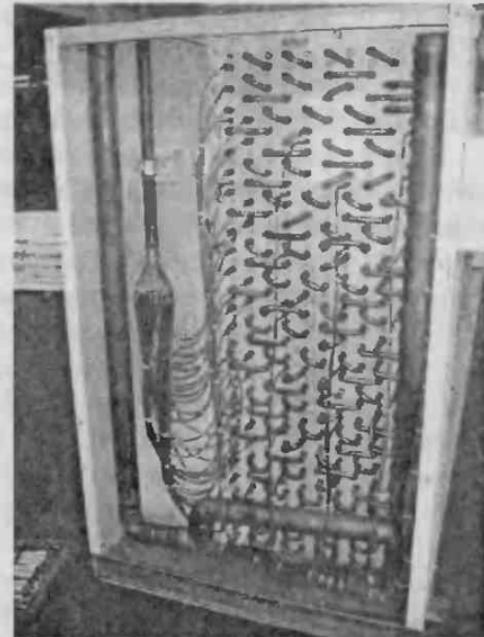
Рис. 2.17. Теплообменный блок воздухоохладителя: жидкостной трубопровод, паук, калачи, парожидкостной трубопровод, кабели для ТЭНов
