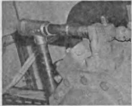
Рис. 2.80. Клапан обратный: а — стальной, установленный на нагнетании аммиачного компрессора; б — латунный, установленный на нагнетании фреонового компрессора
