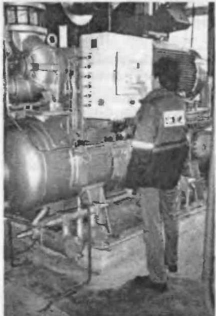
Рис. 3.9. Программирование щита компрессорного агрегата «Мусом»
