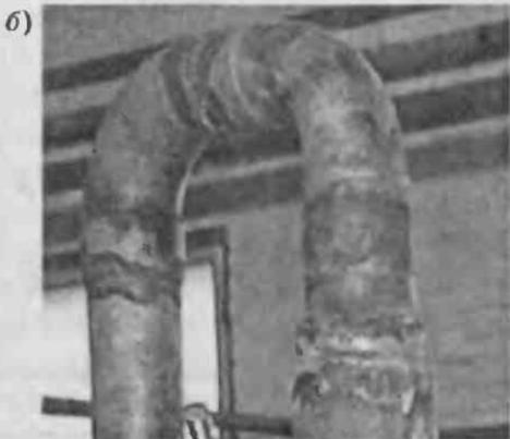
Рис. 2.33. Паяные соединения: а — медь с медью; б — медь со сталью (патрубок аппарата), медь с медью
