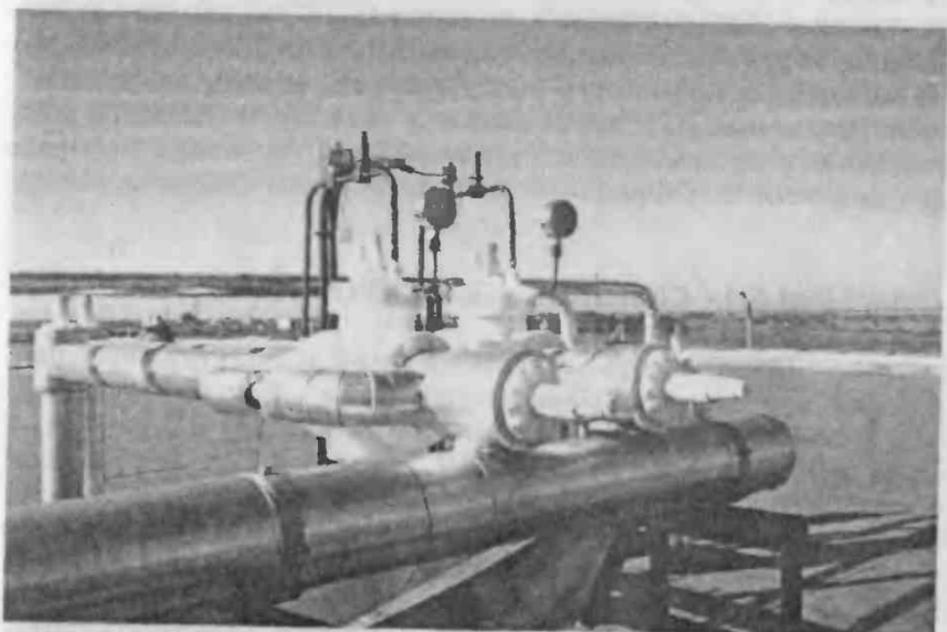
Рис. 2.127. Покровные слои на трассе трубопроводов
