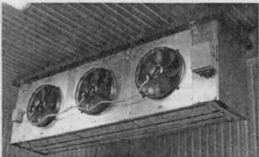
Рис. 2.145. Воздухоохладитель со снятым поддоном; виден ТЭН обогрева поддона
