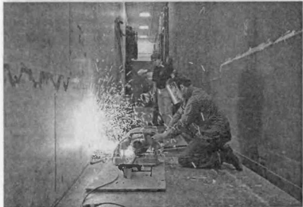
Рис. 2.40. Резка при помощи абразивного круга
