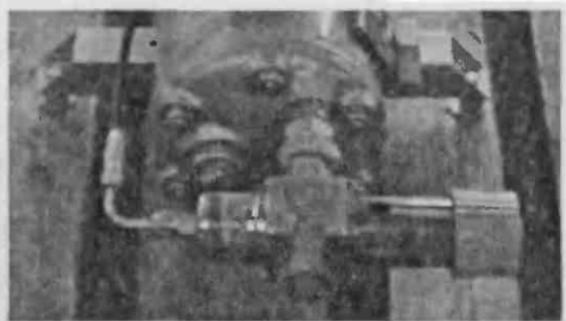
Рис. 2.101. Водорегулирующий вентиль на кожухотрубном конденсаторе
