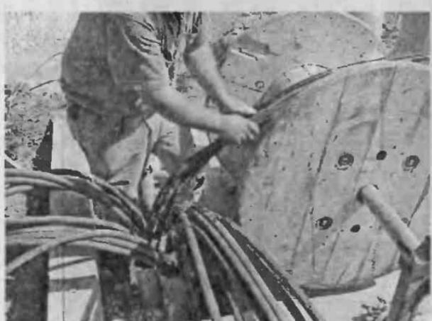
Рис. 2.134. Разматывание кабеля с барабана; видны гильзы
