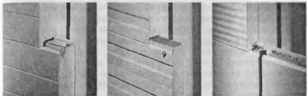
Рис. 2.121. Сэндвич-панели: различные конструкции пазов
