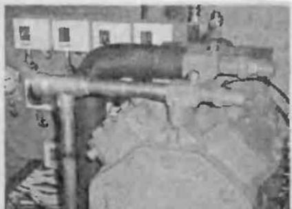
Рис. 2.4. Компрессорное оборудование «Bitzer»: а — компрессорно-конденсаторный агрегат; б — всасывание и нагнетание компрессора (всасывание изолировано, на нагнетании установлен обратный клапан)
