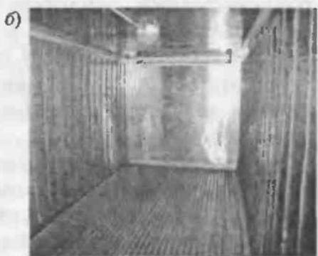
Рис. 2.118. Внешний вид холодильной камеры: а — обшитой оцинкованным железом; б — обшитой алюминиевыми листами
