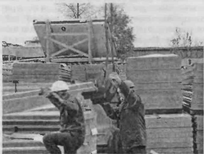
Рис. 1.72. Разгрузка сэндвич-панелей
