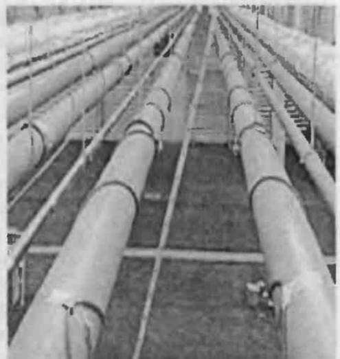
Рис. 2.148. Укладка обогревающего кабеля на трубопроводы оборотной воды
