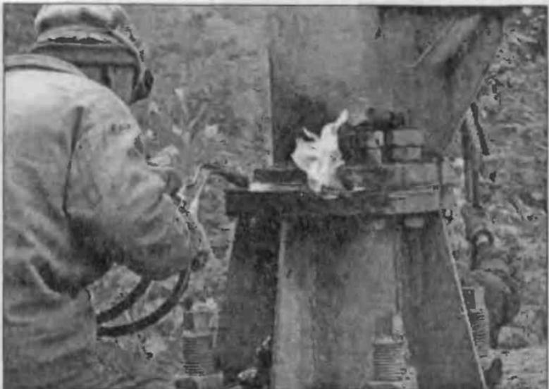
Рис. 2.43. После выжигания краски, разогрева металла газорезчик приступил к резке; видно, как левой рукой рабочий подстраивает вентиль подачи кислорода, потоком которого разрезается металл
