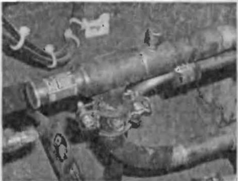
Рис. 2.89. Регулятор давления конденсации марки KVR фирмы «Danfoss»
