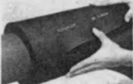
Рис. 2.214. Укладка листового материала на трубу
