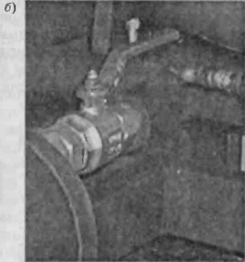
Рис. 2.98. Водозапорная арматура: *а* — дисковый поворотный затвор с рукоятью; *б* — муфтовый шаровый запорный вентиль
