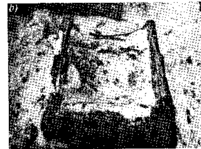
Рис. 6.14. Рамная система покрытия во время эксплуатации а — расчетная схема рамы; б — вид шарнирно-подвижной опоры замонтированной
